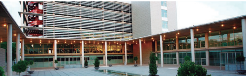
■ Edificio Insur Cartuja (Sevilla)
