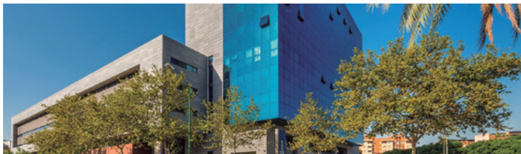
■ Edificio Insur (Sevilla)
