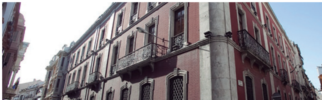
■ Edificio García Lovera (Córdoba)
