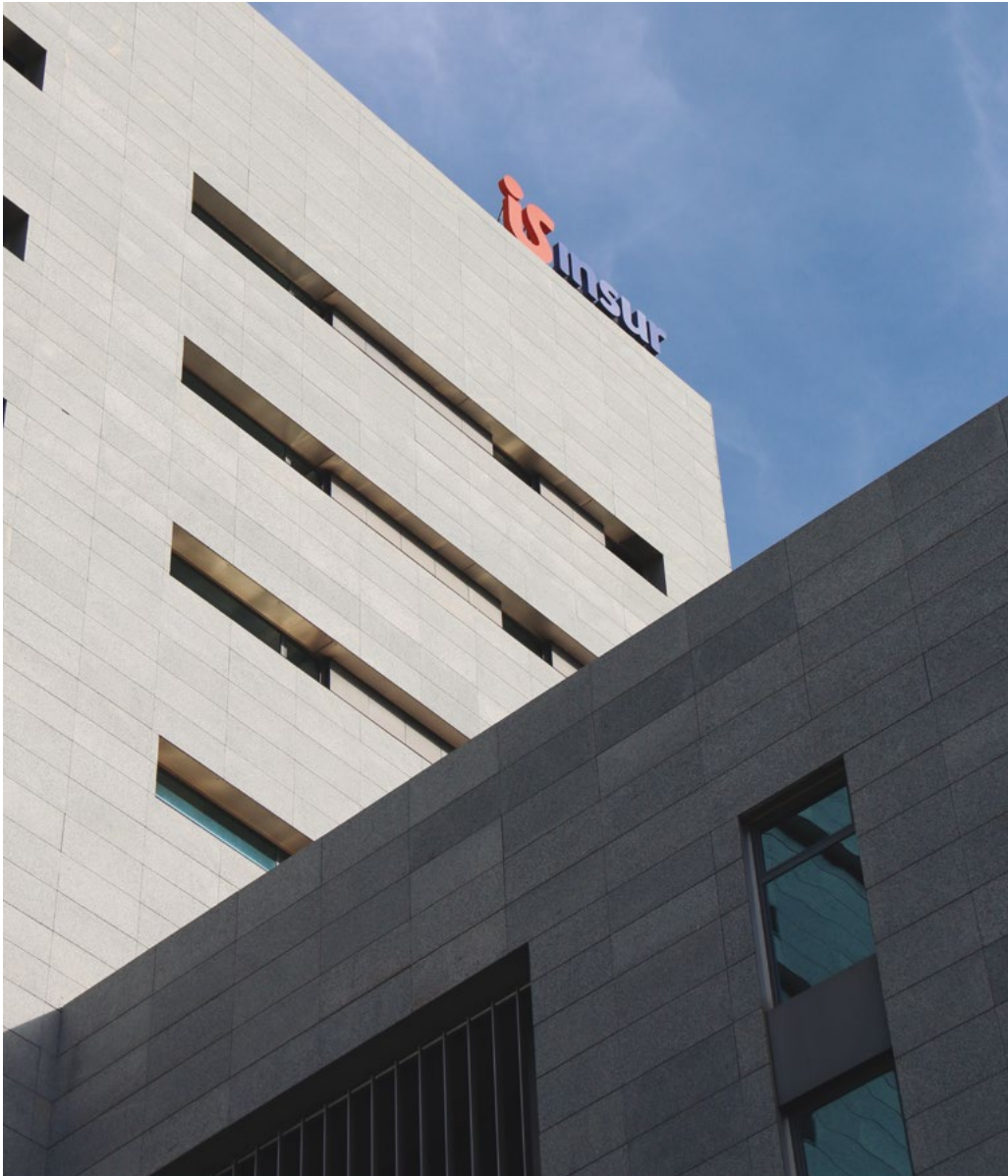
■ Edificio Insur (Sevilla)
