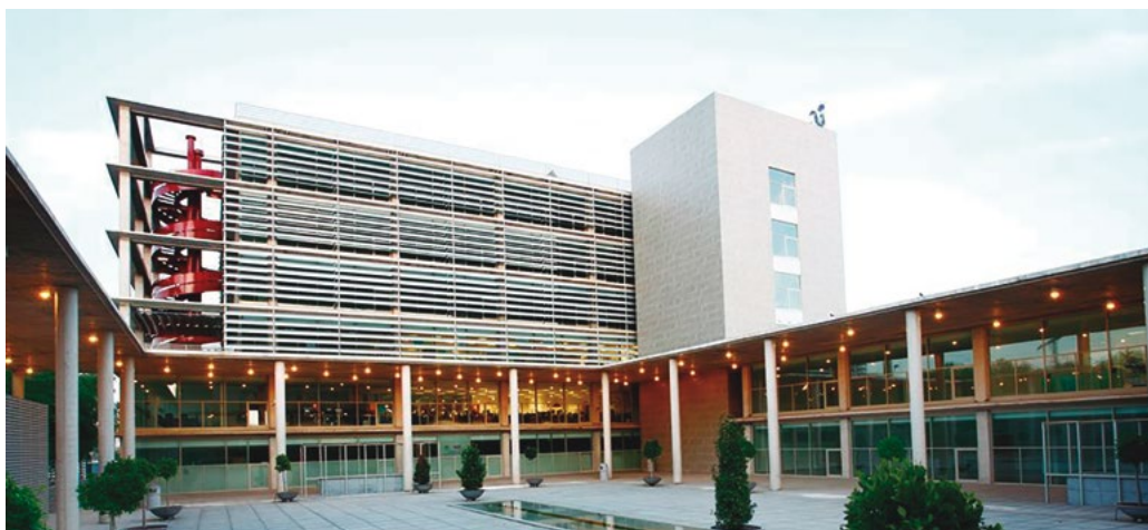
■ Edificio Insur Cartuja (Sevilla)
