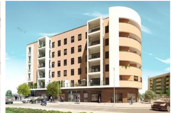
Edificio Galileo (Mairena del Aljarafe, Sevilla)
