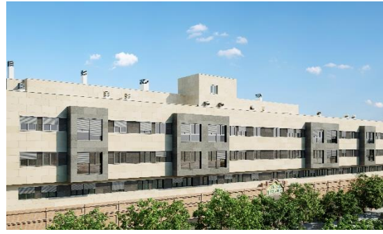
Edificio Miraflores (Sevilla)
