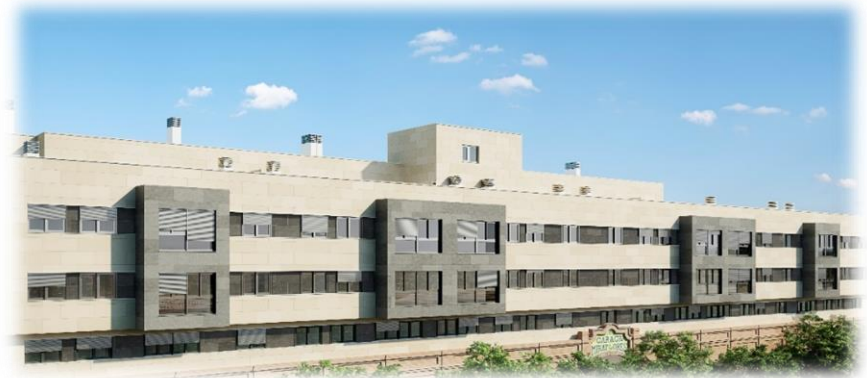
Edificio Miraflores (Sevilla)
