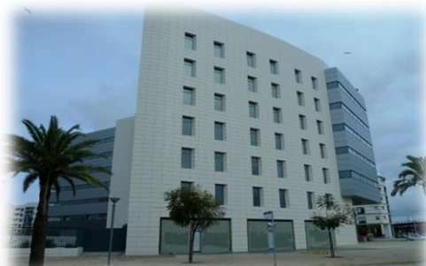
Edificio Insur Huelva (Huelva)
