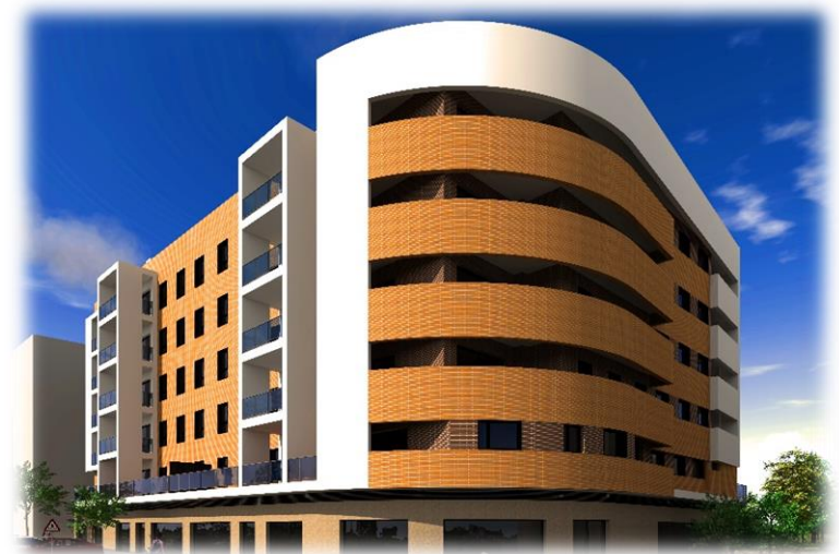
Edificio Galileo (Mairena del Aljarafe, Sevilla)
