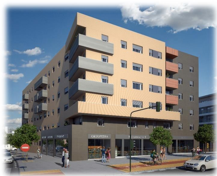
Edificio Bellasierra (Córdoba)
